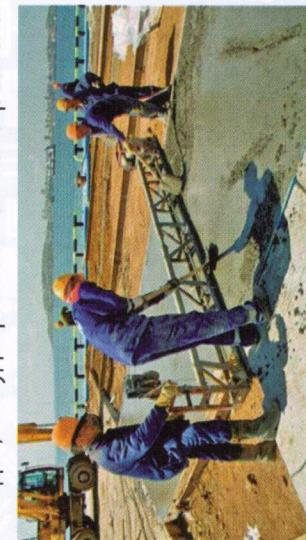
Бетонщики разравнивают бетонную смесь, а затем уплотняют. Уплотнив бетон, рабочие разглаживают поверхность, чтобы она стала прочной и ровной. Также в обязанности рабочего входит слежение за температурой затвердевающего бетона, утепление его, так как бетон необходимо высушивать определенное время при определенной температуре.
